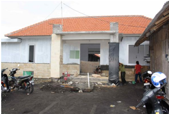
Voorzijde receptiegebouw met kantoren
